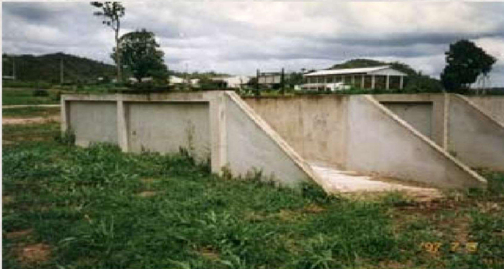
หลุมหมักแบบกำแพงคอนกรีต (ขนาดกว้าง 1.6 ม. ยาว 5 ม. สูง 1 ม.)
